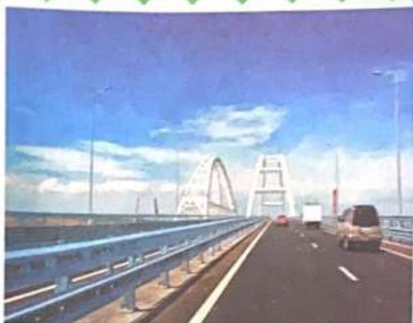
Мост через Керченский пролив
